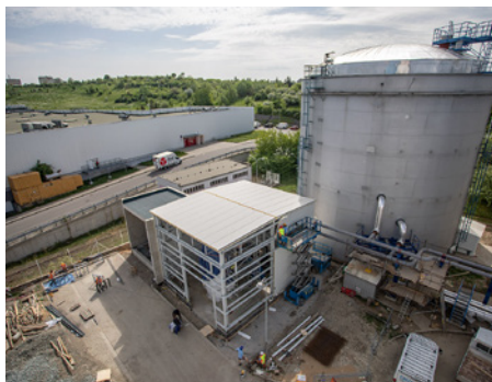
26. dubna. Práce na střeše a opláštění budovy
