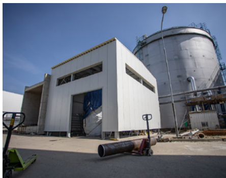
3. května. Zahájení prací na elektroinstalaci
