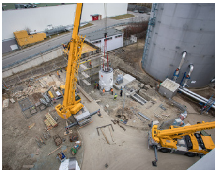
27. března. Usazování elektrodového kotle
