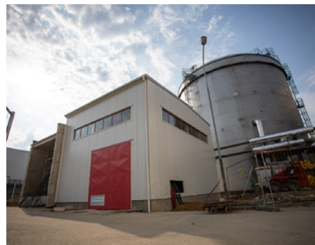
18. června. Dokončení elektroinstalace a finální terénní úpravy
