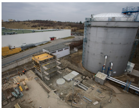
20. března. Příprava základů pro instalaci elektrodového kotle
