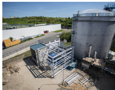
20. dubna. Výstavba konstrukce budovy
